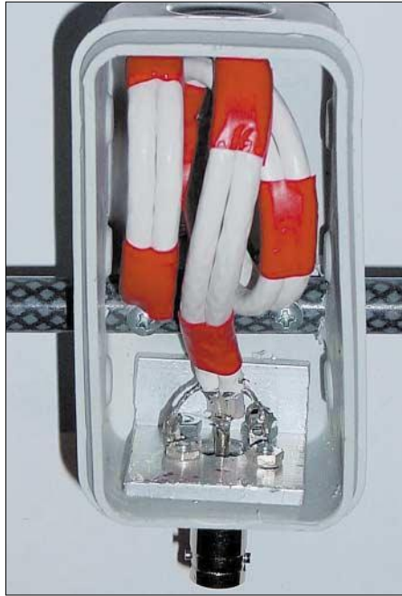
Bild 8: Dose der 28-Ω-Yagi mit 2 x 75-Ω-PE-Kabel
